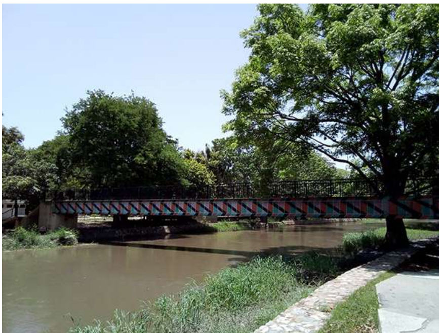
Rio Manzanares Puente peatonal Guzman Blanco
